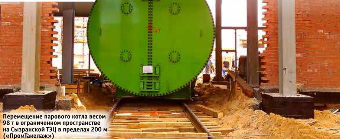
Перемещение парового котла весом 98 т в ограниченном пространстве на Сызранской ТЭЦ в пределах 200 м («ПромТакелаж»)
