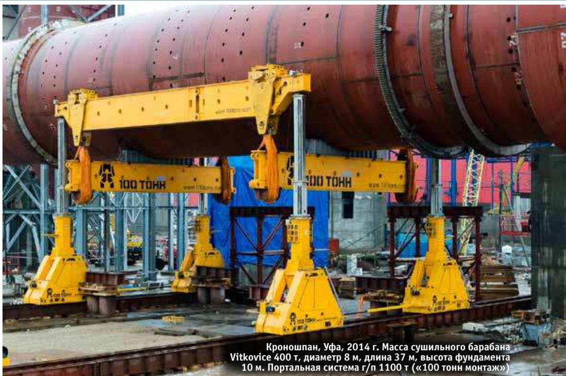
Кроношпан, Уфа, 2014 г. Масса сушильного барабана Vitkovice 400 т, диаметр 8 м, длина 37 м, высота фундамента 10 м. Портальная система г/п 1100 т («100 тонн монтаж»)
