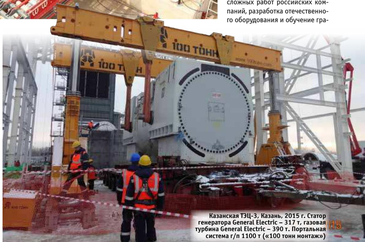
Казанская ТЭЦ-3, Казань, 2015 г. Статор генератора General Electric – 317 т, газовая турбина General Electric – 390 т. Портальная система г/п 1100 т («100 тонн монтаж»)
