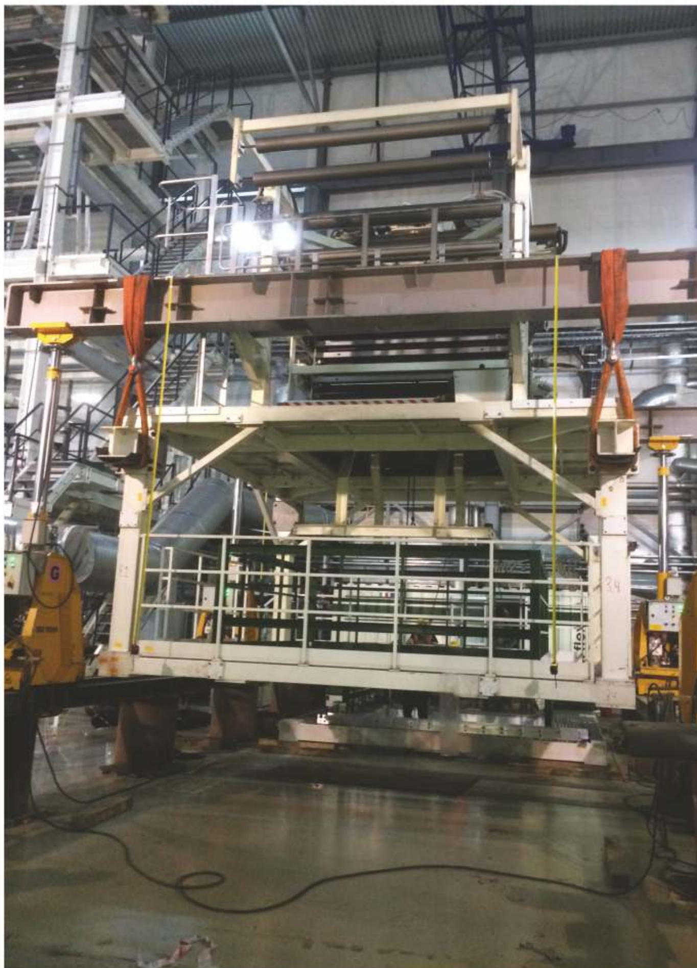
Союз-Полимер, 2019 г., Свердловская область, Арамилы, Челябинская область, Копейск Релокация экструзионной машины Maschi. Демонтаж в условиях действующего производства. Портал GP60
