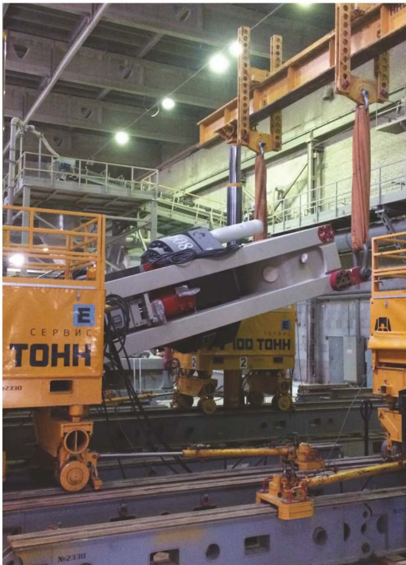
Завод керамических изделий, 2017 г., Екатеринбург Разгрузка, перемещение в цех, кантование и установка в приямок двух прессов. Портал GP500
