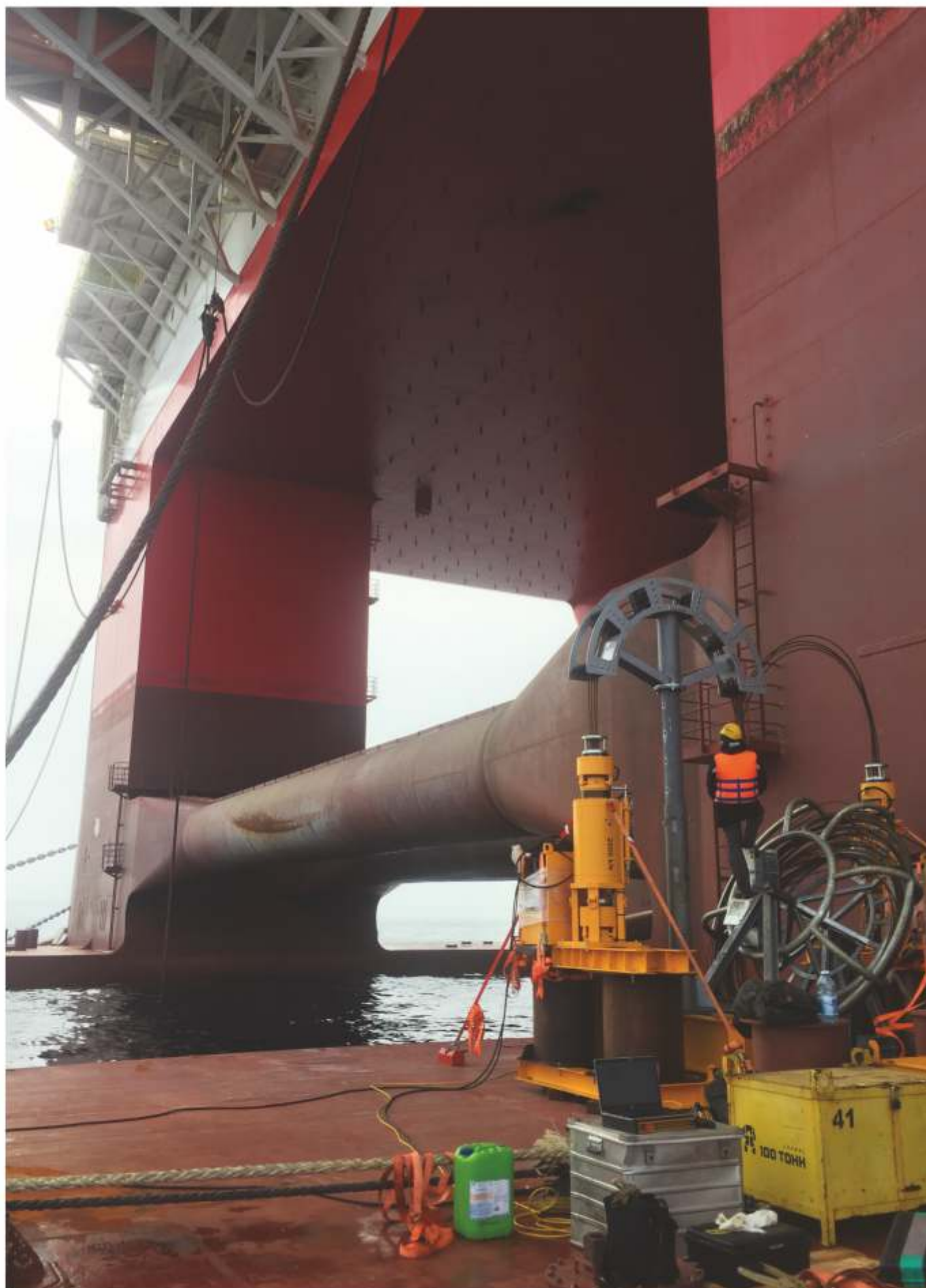
Полупогруженная плавучая буровая установка «Северное сияние», 2021 г., Японское море, залив Находка Демонтаж четырех винторулевых колонок.
