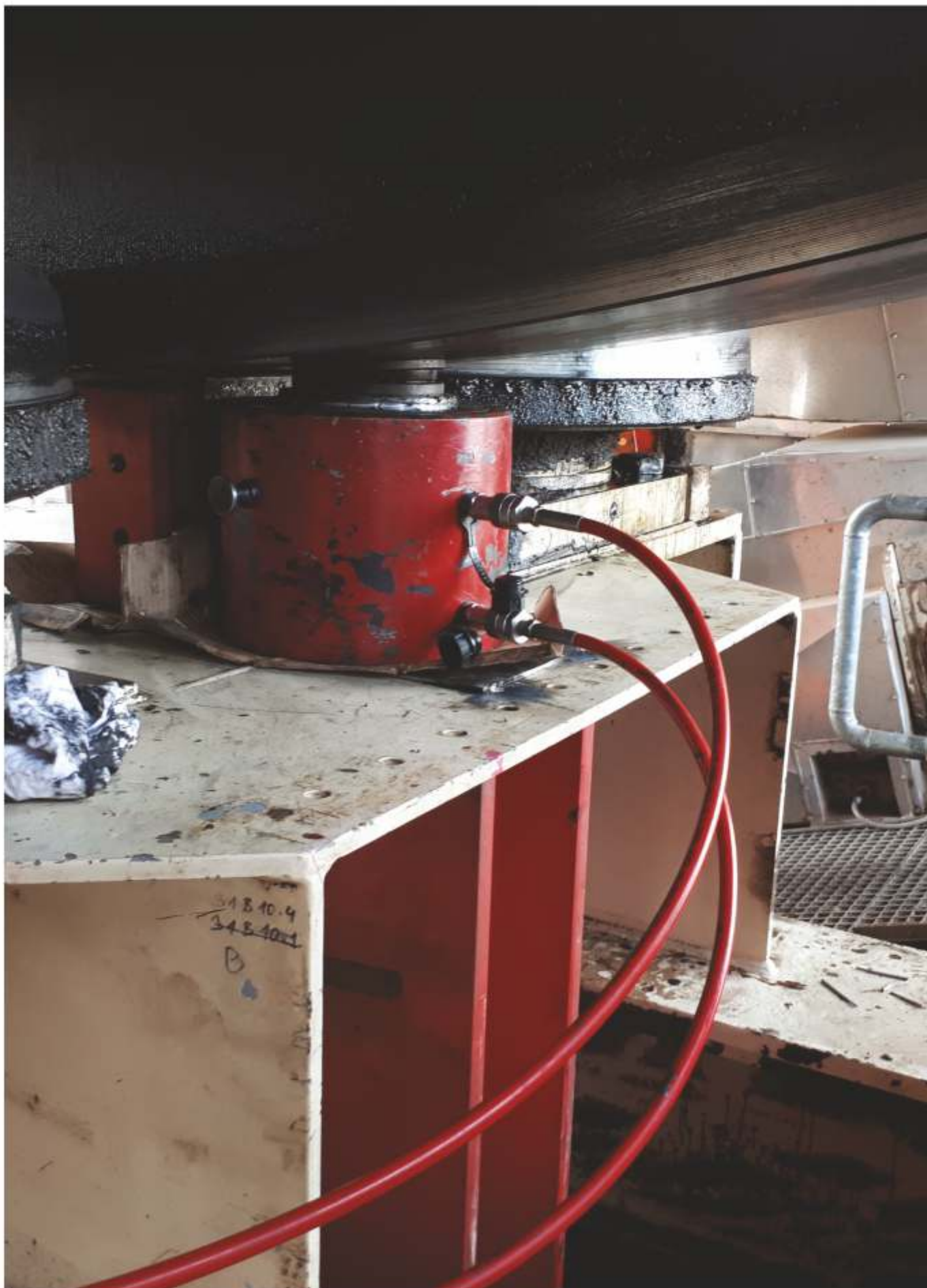
Фабрика Кроношпан, 2017 г., Уфа Подъем сушильного барабана массой 450 т для проведения ремонта
