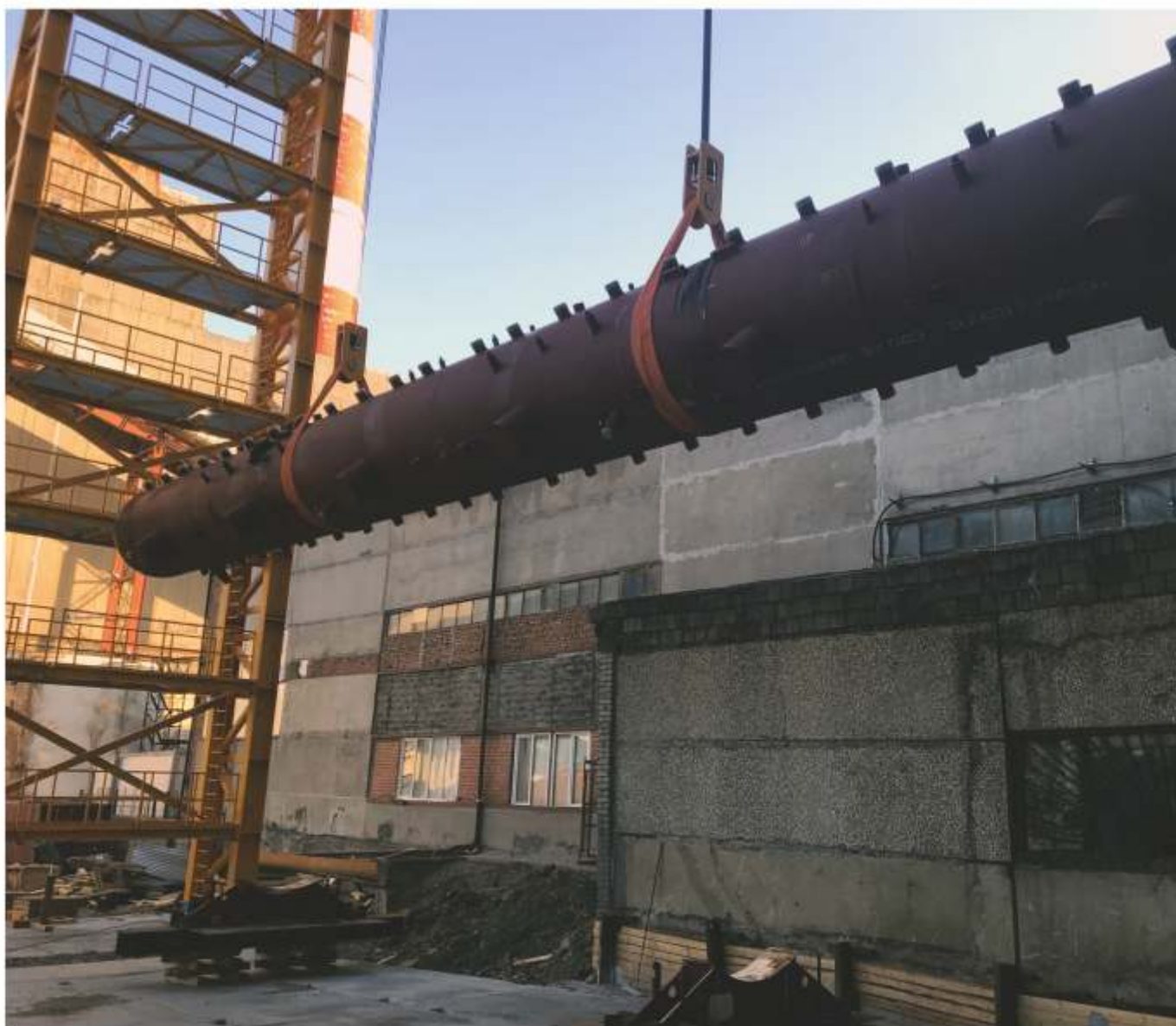
Гусиноозёрская ГРЭС, 2021 г., Бурятия, Гусиноозёрск Подъем барабанов на высоту 43 м, перемещение через проем внутрь здания и установка в проектное положение
