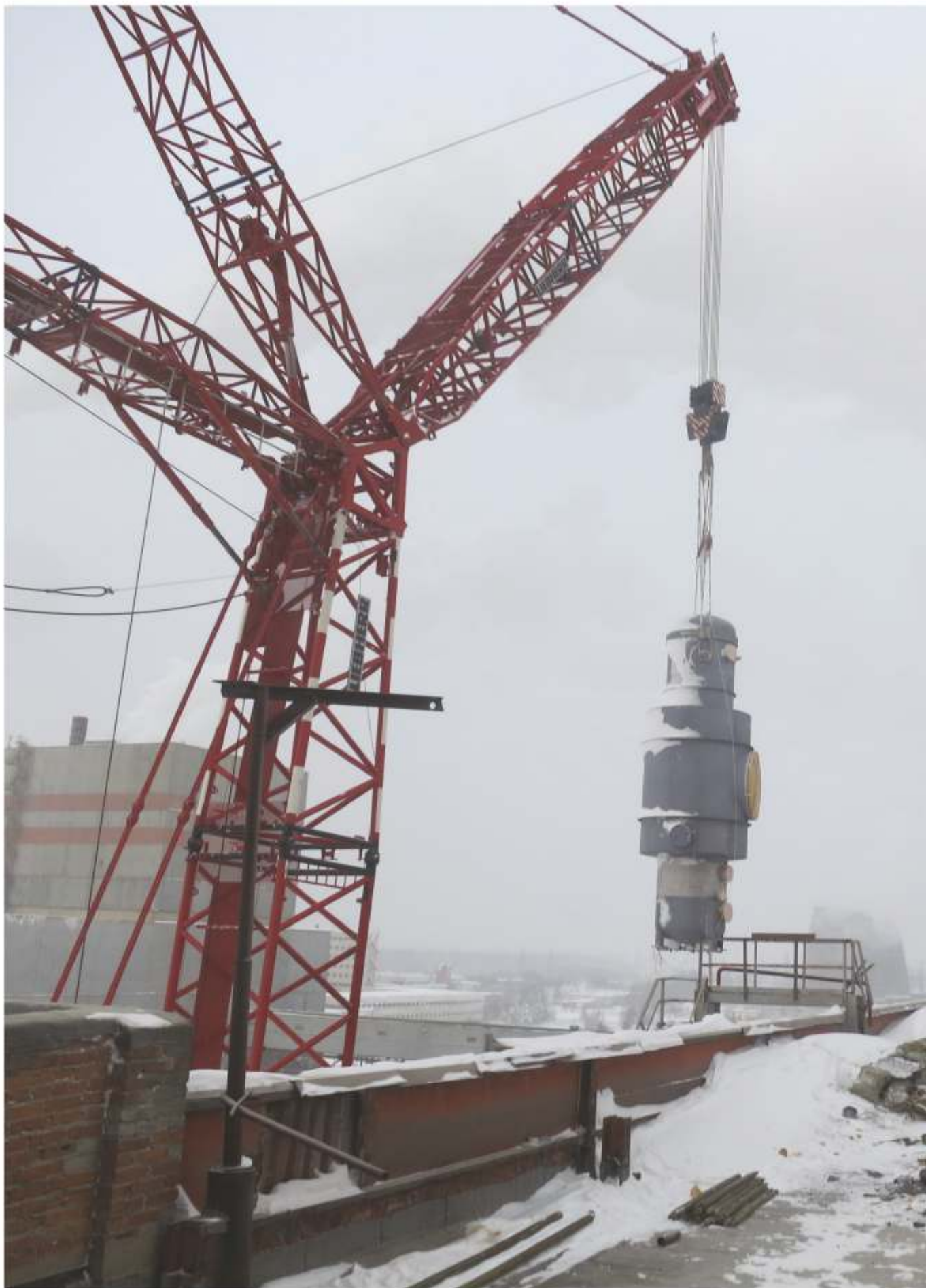
Целлюлозный завод группы Илим, 2017 г., Иркутская область, Усть-Илимск Монтаж оборудования выпарных станций
