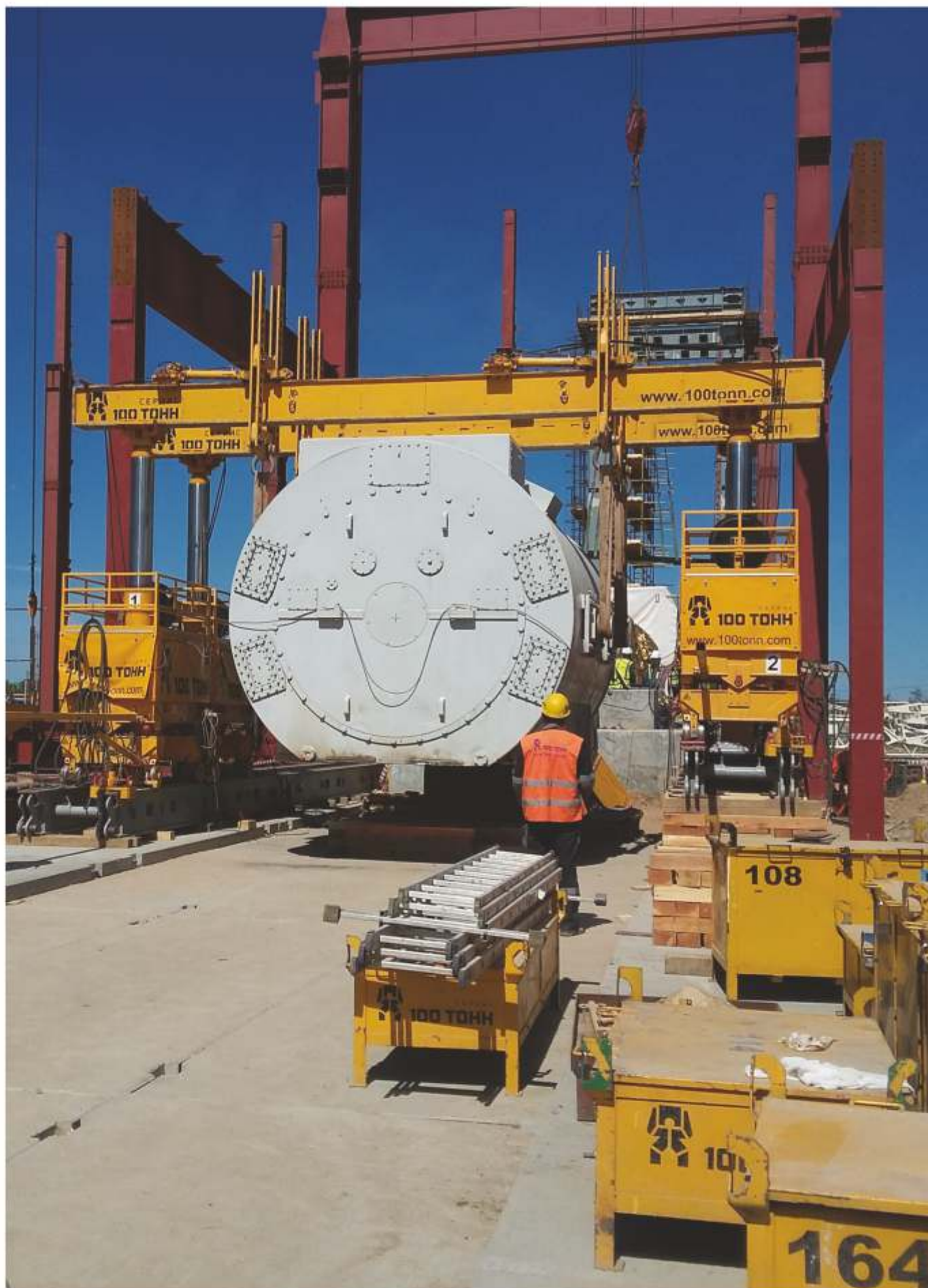
Прегольская ТЭС, 2017 г., Калининград Установка оборудования общей массой 968 т параллельно со строительством машинного зала. Портал GP500
