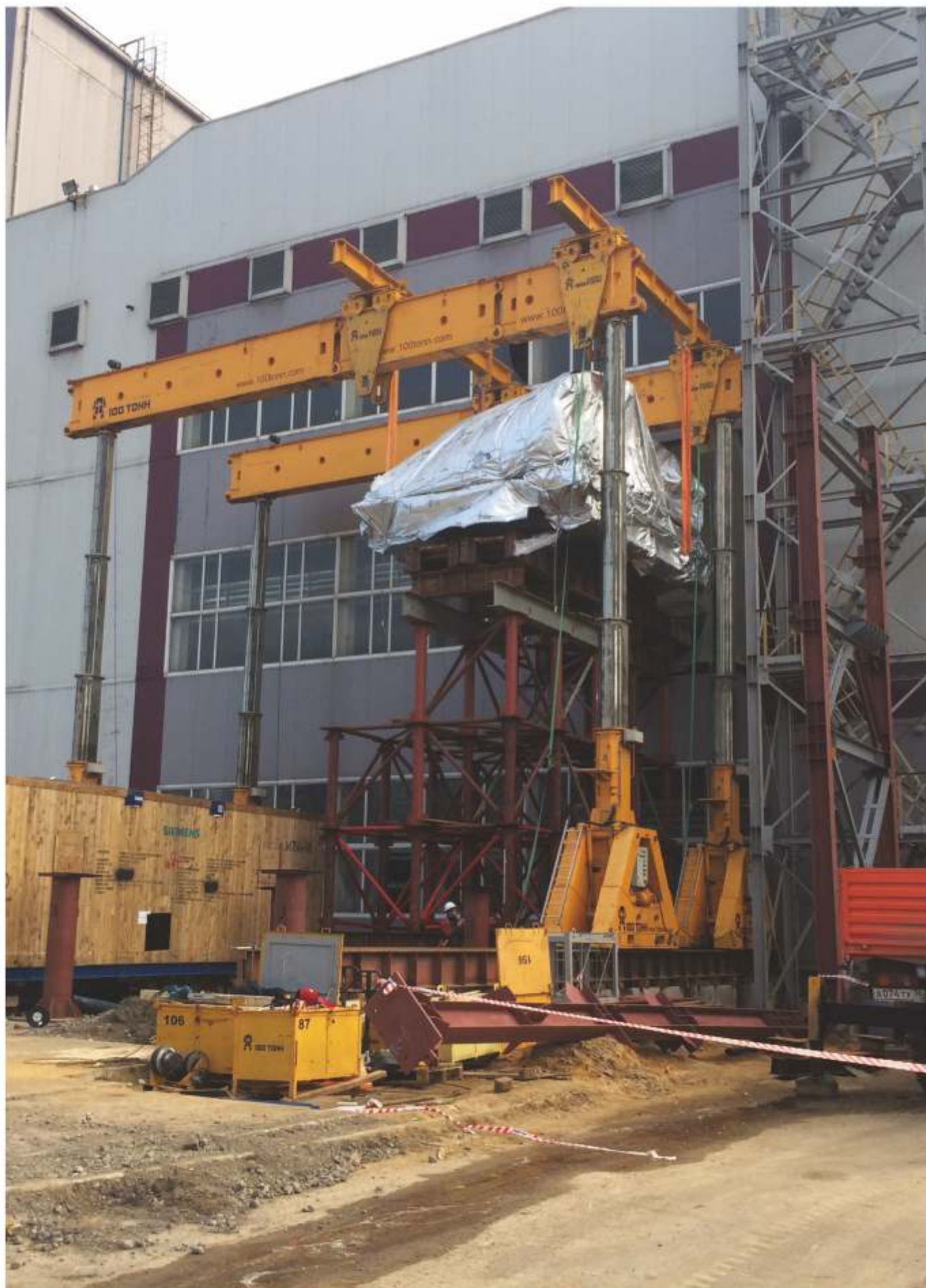
УТЭЦ ПАО НЛМК, 2018 г., Липецк Подъем, перемещение и установка турбины и компрессора Siemens. Стыковочные балки и портал GP1100
