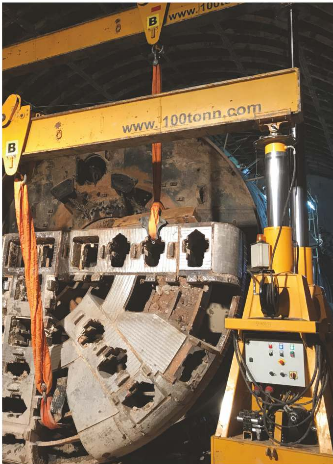
Московский метрополитен, 2020 г., Москва Демонтаж проходческого комплекса Robbins. Портал GP125
