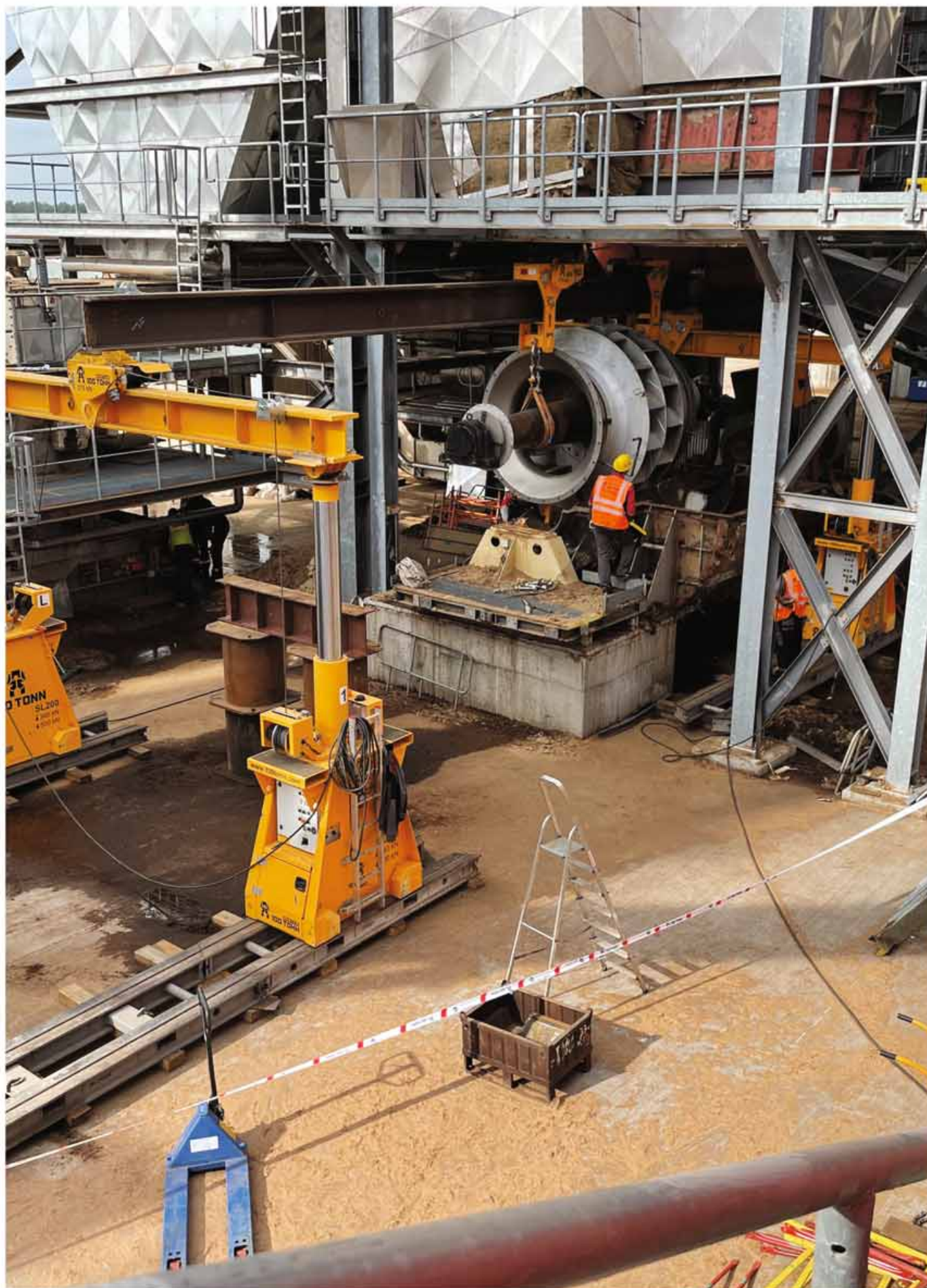
Кроношпан Башкортостан, 2021 г., Уфа Демонтаж и монтаж крыльчатки вентилятора. Портал GP200
