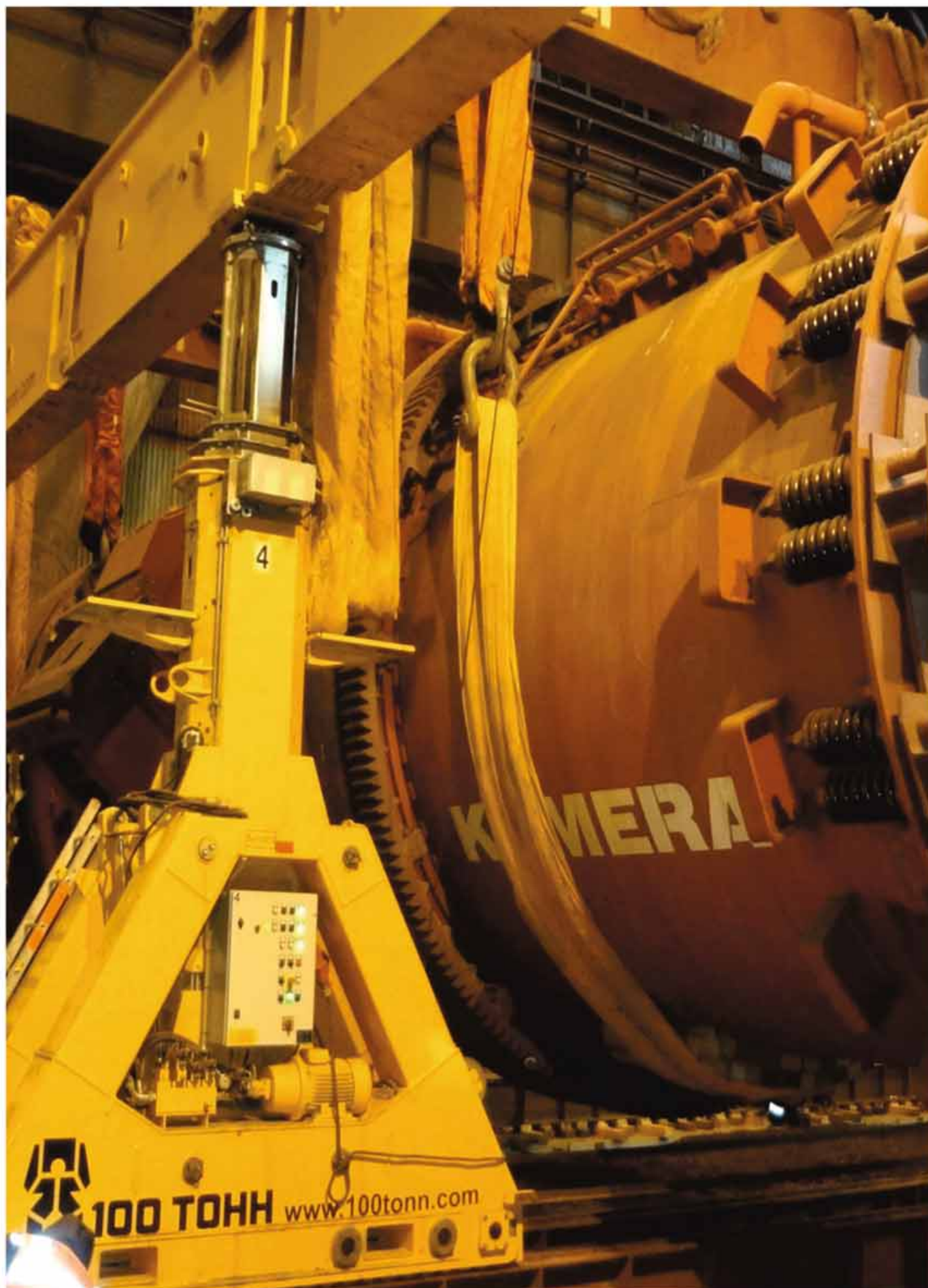
Карабашмедь, 2013 г., Челябинская область, Карабаш Демонтаж старой печи массой 400 т, монтаж новой печи KUMERA массой 516 т. Портал GP1100
