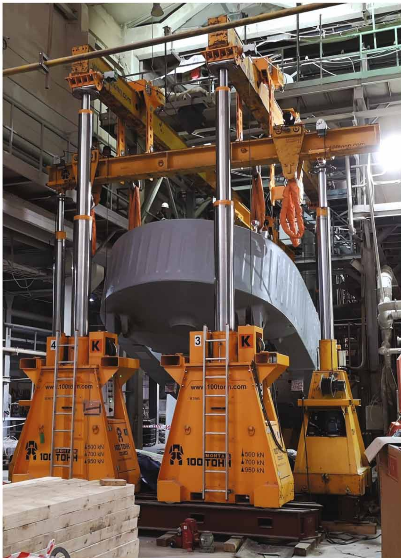
Самарский Стройфарфор, 2018 г. Самарская область, Стройкерамика Демонтаж и монтаж оборудования по производству керамогранитной плитки. Порталы GP380 и GP125
