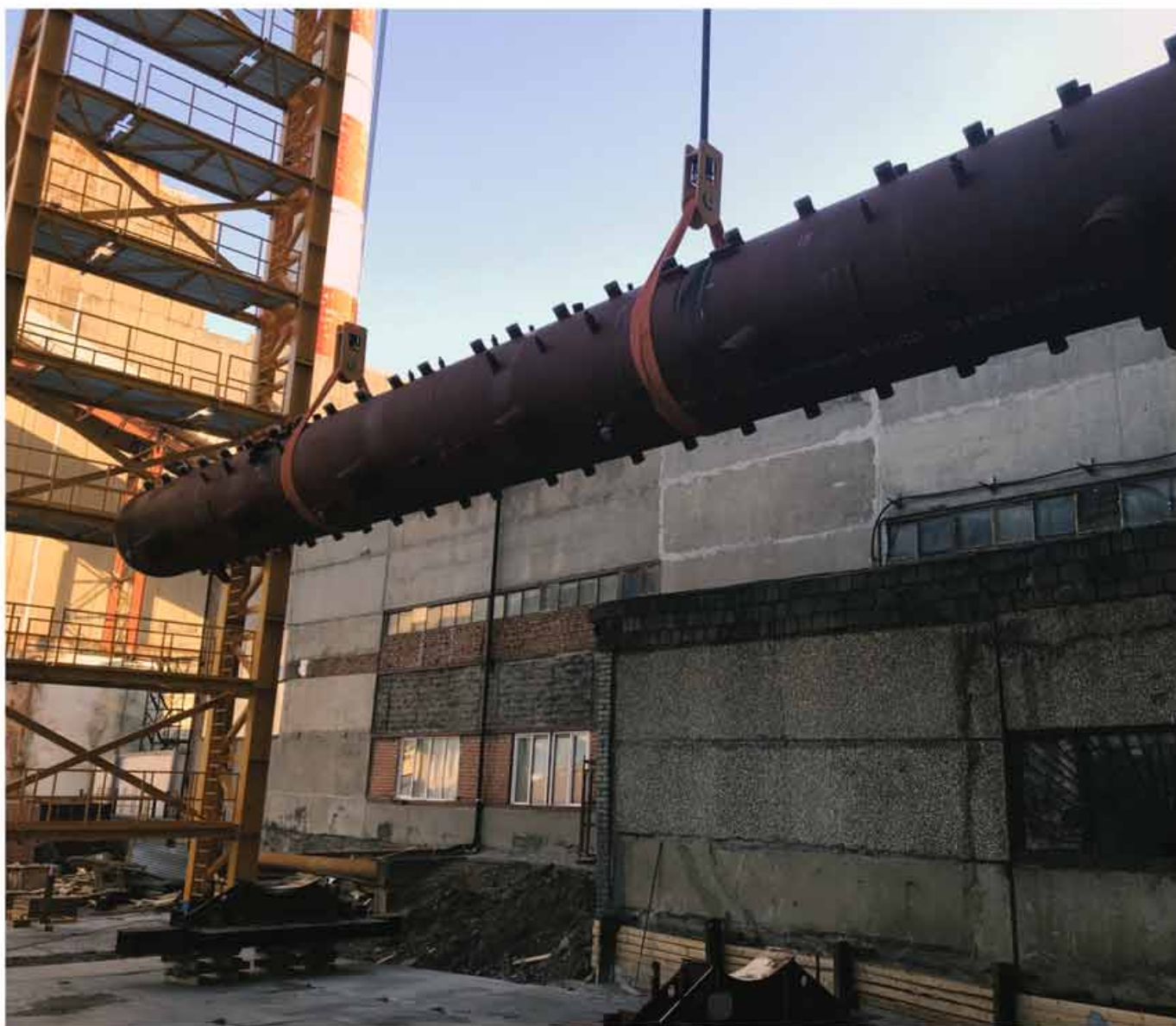
Гусиноозёрская ГРЭС, 2021 г., Бурятия, Гусинозёрск Подъем барабанов на высоту 43 м, перемещение через проем внутрь здания и установка в проектное положение
